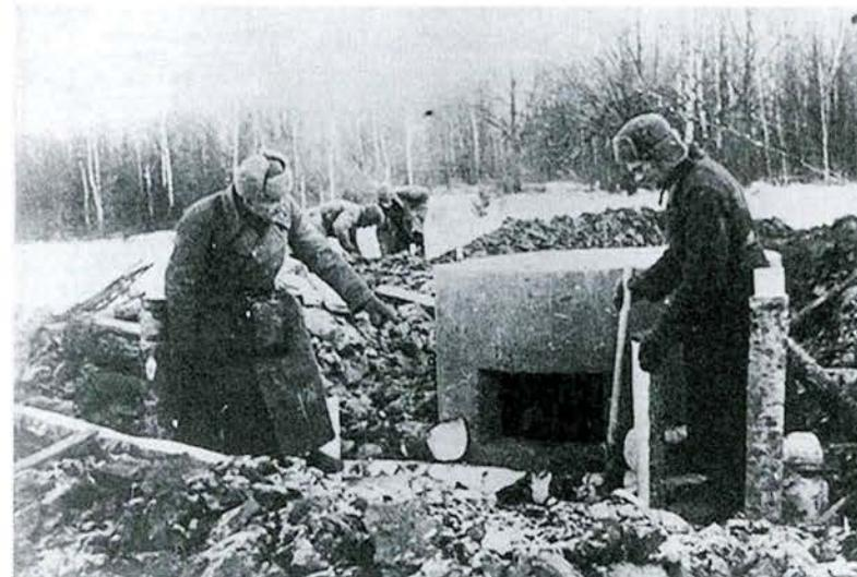
Фото 1. Установка пулемётного колпака на огневом рубеже.
