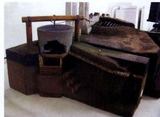
Макет 1. Бронированная пулемётная точка с широким сектором обстрела (железобетонный колпак подвешен и может вращаться вокруг своей оси).
